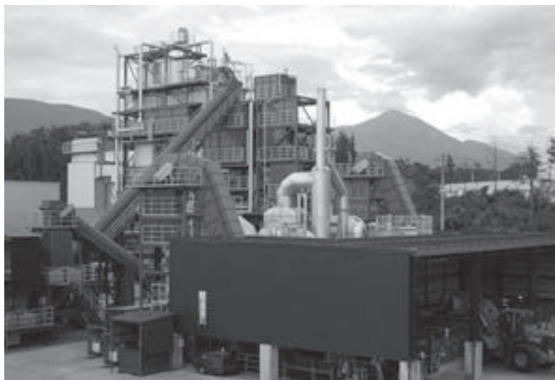
グリーン発電会津の木質バイオマス発電所
