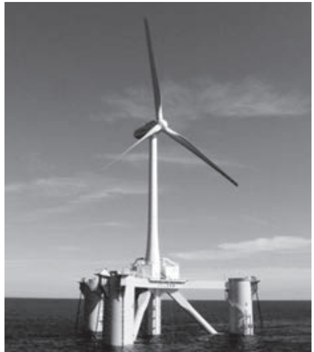
福島沖に設置した出力2000kw級の浮体式洋上風力発電（福島洋上コンソーシアム提供）
