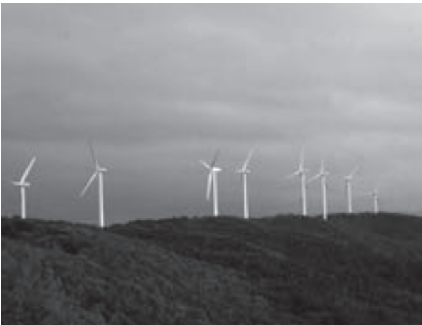
エコ・パワーの風力発電設備
