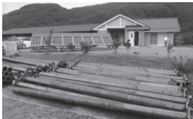
熱交換井として使う基礎杭（手前）と住環境設計室の実証住宅（後方）
