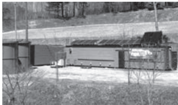
川内村に設置したミニバイオマスエコロジーシステム
