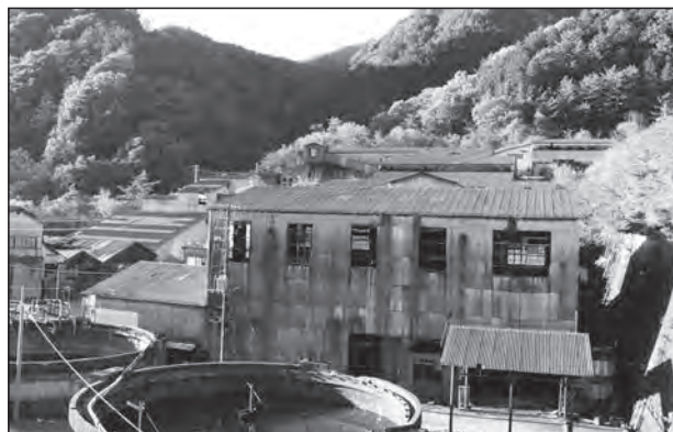
銅精錬所跡の貯水槽
