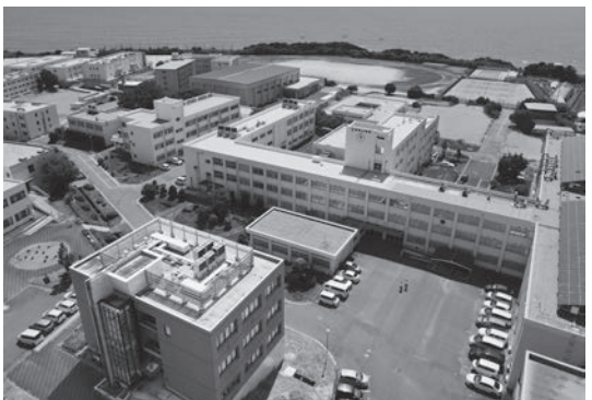
和歌山県御坊市に本校を置く和歌山高専(校舎全景)
