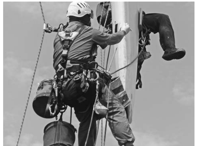
重機を使わず認定技術者がロープワークで点検から補修まで対応する（イー・ウィンド提供）
