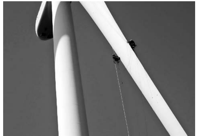
風力発電の保守作業（イー・ウィンド提供）
