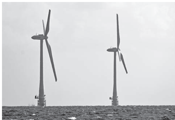
26年完成に向け増設が進む日本初の浮体式洋上ウインドファーム
