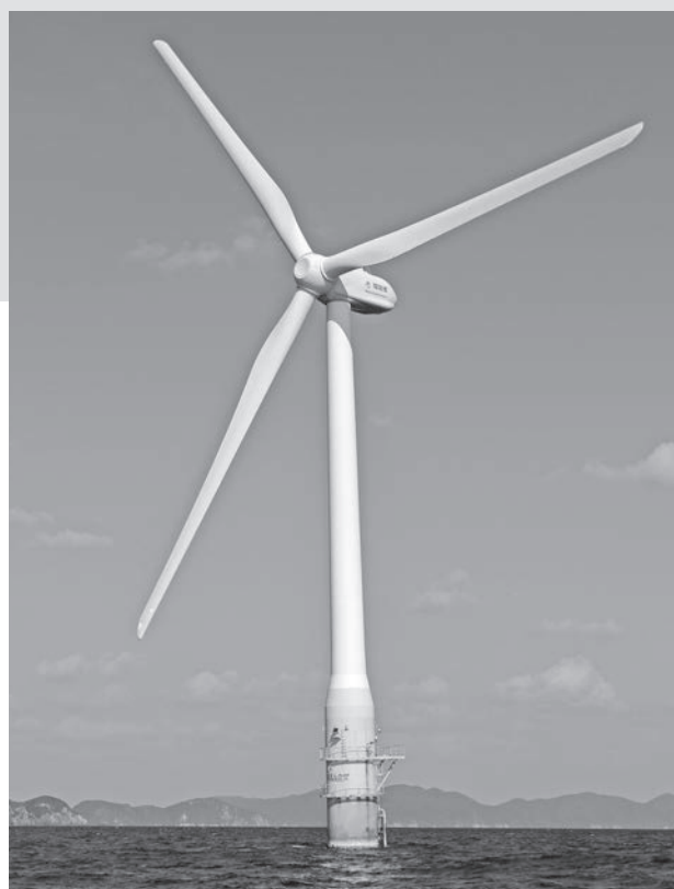
崎山沖5キロメートル地点で稼働する 浮体式洋上風力発電「はえんかぜ」
