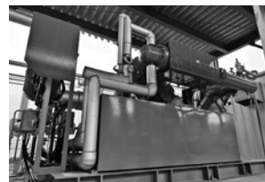
バイオガス圧縮機で吸蔵容器から降ろしたガスを0.85MPaまで昇圧させる
