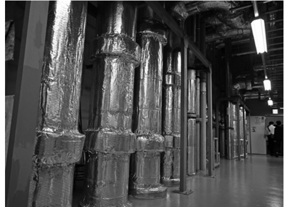
廃熱は地上に放出せず、病院内に張り巡らされたパイプを通してヒートポンプに集められる
