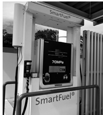
公用車や民間のFCV、FCフォークリフトなどに水素を供給している（水素ディスプレイセンサー）
