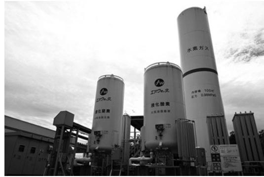
バイオガス精製設備で抽出されたメタンガスは触媒環境下で水蒸気と反応させて水素を発生させる。(右は水素貯蔵設備、左は水素製造装置)
