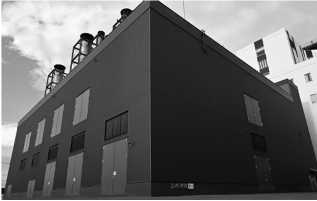
病院に隣接するエネルギーセンター棟。日本ファシリティ・ソリューションがエネルギーシステムを管理・運用している
