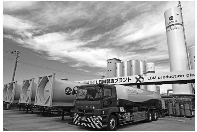
LBM製造プラントではバイオメタンをマイナス160°Cの極低温まで冷却して液化する。環境に優しいカーボンニュートラルなLNG代替燃料として利用可能だ
