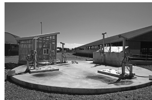
ふん尿が保管されるバイオガス処理設備の地下ピット。 順次、地上にある発酵槽2基に送られる
