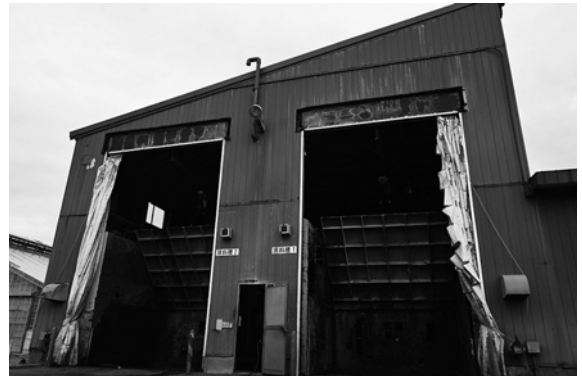
乳牛ふん尿を貯蔵する原料槽（中鹿追バイオガスプラント）
