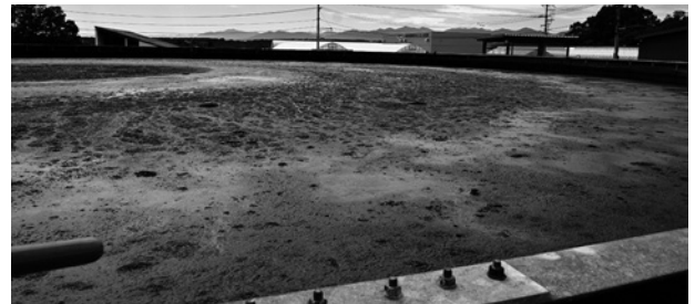
メタン発酵後の消化液は液体有機肥料として活用（消化液貯留槽）
