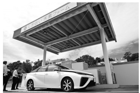
しかおい水素ファームに併設された水素ステーション
