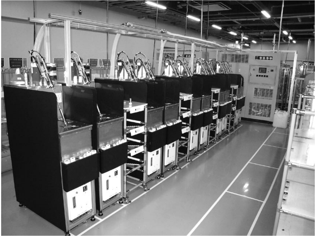
図1：HFE 排ガス回収装置（手前）と液化回収設備（奥）
