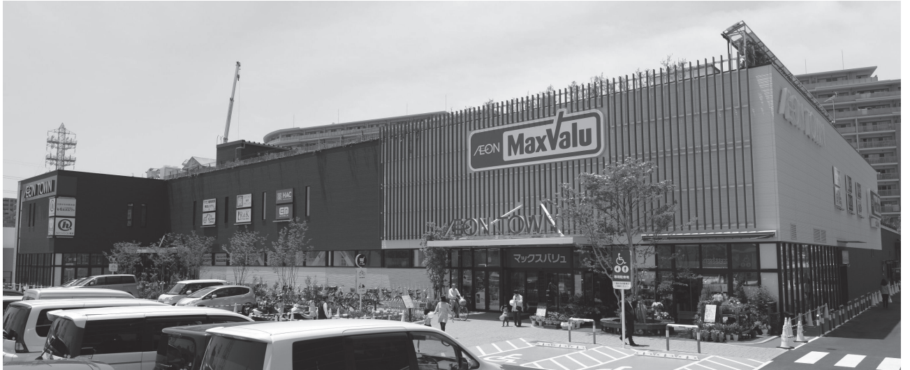
自然冷媒機器が導入されているマックスバリュ新船橋店外観
