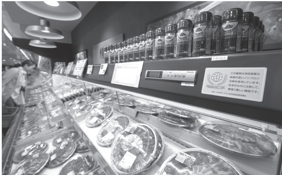
自然冷媒を使っている冷蔵什器（マックスバリュ新船橋店）
