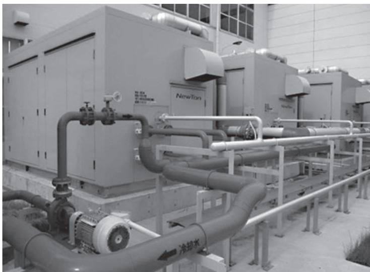
$\text{NH}_3/\text{CO}_2$ 冷凍機ユニット（山形工場）
