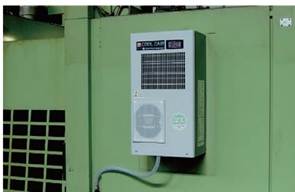
制御盤用クーラ「COOL CABI」
