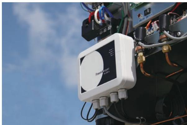
フロン漏えい検知システム「フロンキーパー」の外観
