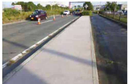
ランドが開発した雑草防止土系舗装材「頑太郎」は、安全性が確認されている複数のセラミックス化した廃棄物を原料とし、混合した舗装材。水を混ぜるだけで固まるため簡単に施工でき、材料同士が強く結合することから雑草が生えない。また夏は1日で歩行可能程度にまで硬化するため、施工作業を効率化できる。
